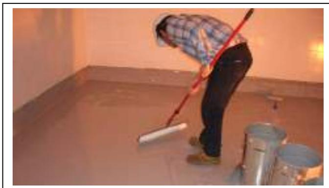
Als de eerste laag (primer) is gedroogd mag de volgende watervaste laag van ongeveer  $1\frac{1}{2}$  kg/m<sup>2</sup> aangebracht worden, gemixt met snel droger (1,5L/ 25 kg IMPERMAX) met een spatel met tanden van ongeveer 3,2mm hoogte en 28cm breed. Hierbij is het van belang dat de tanden driehoekig zijn zodat ze zo min mogelijk sporen achterlaten en de zelfverdeling van het produkt toestaan. Het produkt moet rustig worden aangebracht en belletjes moeten vermeden worden.
