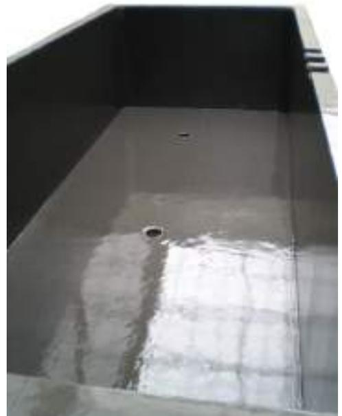
Die Wartezeit (=Trocknungszeit) zwischen dem Anbringen der einzelnen Schichten ist absolut wetter- und temperaturabhängig und von der Luftfeuchtigkeit.
