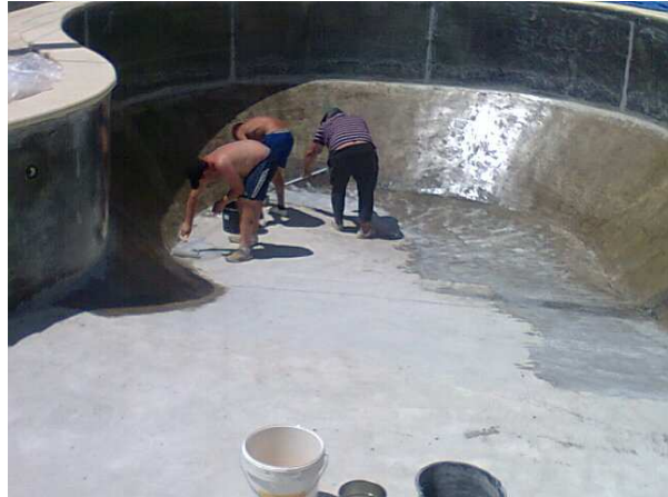
4. Schritt: Auftragen von Impermax, blau
